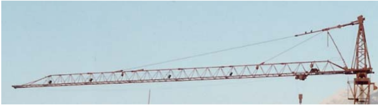
Isostatische Doppelabspannung des Auslegers bei einem alten Pingon Kran auf den Obergurt.
