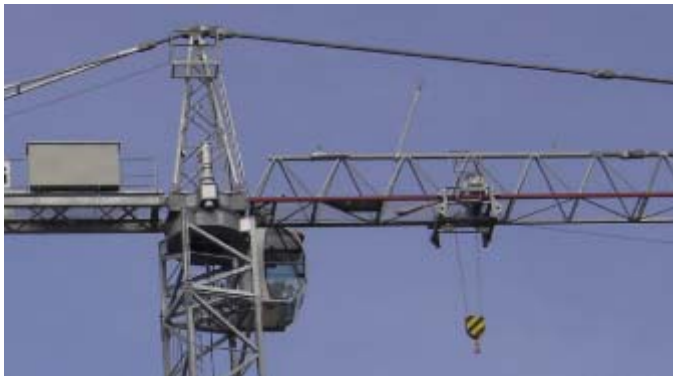
Zugstangenabspannung mit Hilfsbock an einem Swiss – Crane ML Kran. Bei der Montage wird der Ausleger mit dem Mobilkran soweit aus der Horizontalen angehoben bis die Verbolzung an der Abspannstange direkt montiert werden kann.
