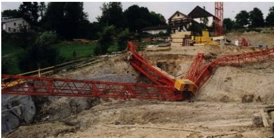
Kranumsturz durch Grundbruch, glücklicherweise ist nur Sachschaden entstanden
