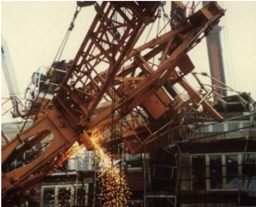
Korrekte Wartung zahlt sich aus. Im Bild ein durch Versagen der Drehkranzverschraubung abgestürztes Kranoberteil
