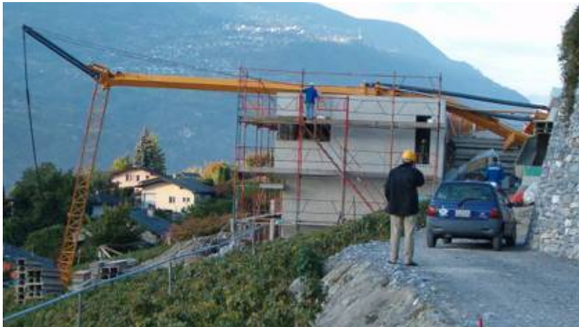
Keine Manipulation an den Überlasteinrichtungen vornehmen! Im Bild ein durch massive Überlast umgestürzter Schnellmontagekran, es blieb glücklicherweise beim Sachschaden. Der Kran erlitt Totalschaden.
