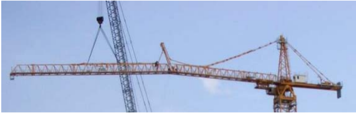
Montage des vorderen Auslegerstücks an einem 3150 HC.
