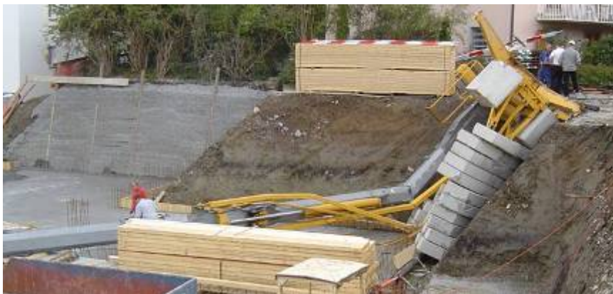
Ebenfalls durch Überlast ist dieser Schnellmontagekran umgestürzt
