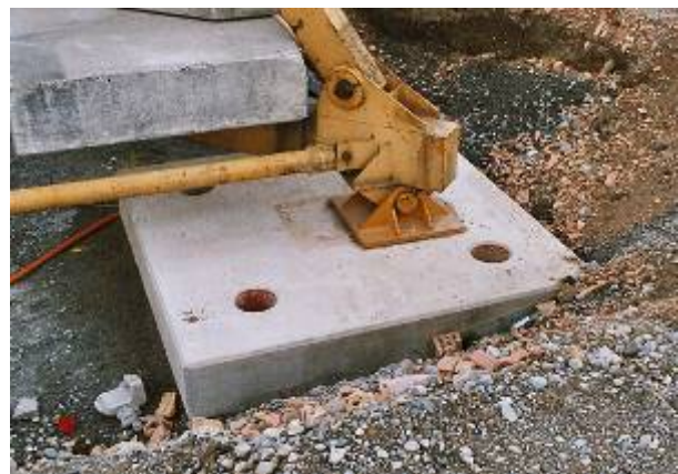
unsauber versetzte Fundamentplatte
