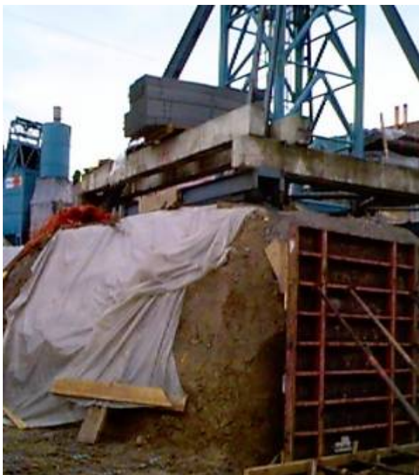
Böschungswinkel nicht eingehalten, notfallmässige Spriessung
