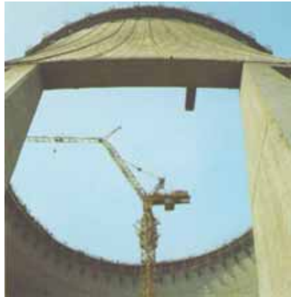
Abbildung 2-7: Oben drehender Knickausleger beim Kühlturmbau [Lie-86]
