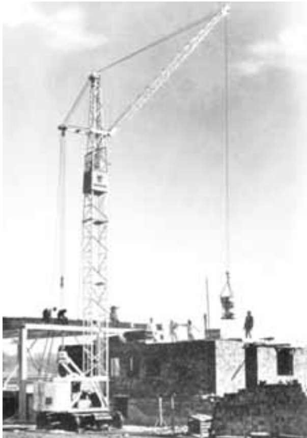
Abbildung 2-7: Oben drehender Knickausleger beim Kühlturmbau [Lie-86]
