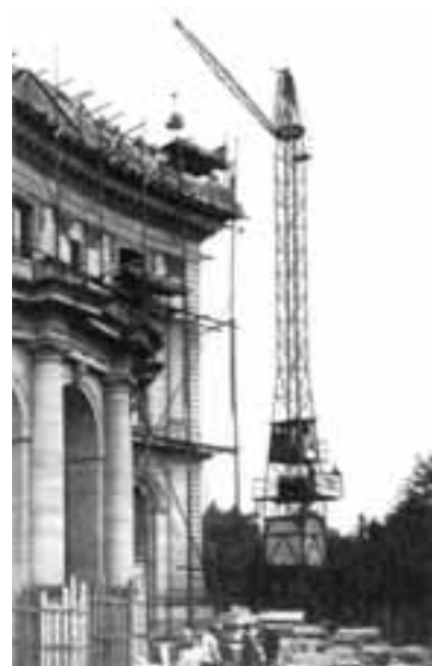
Abbildung 2-5: Erster schnell montierbarer Baukran [Bac-97]
