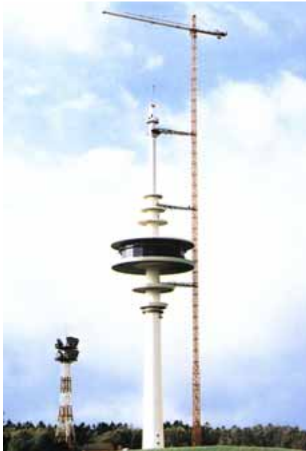
Abbildung 2-26: Außenklettern beim Bau eines Fernsehturms [Wol-95]
