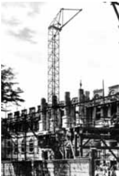
Abbildung 2-4: Fahrbarer Kranmast [Bac-97]
