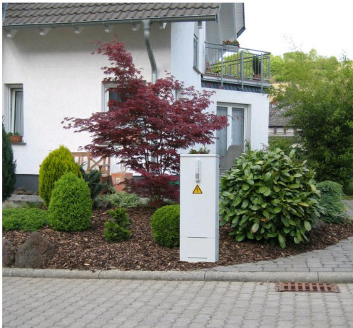
**Bild 8:** Beispiel für eine Haus-/Zähleranschlusssäule (Quelle: Energienetze Mittelrhein GmbH & Co. KG)
